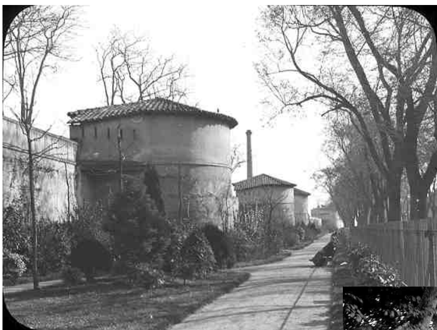
Les remparts médiévaux boulevard Armand Duportal, photographiés dans la première moitié du XX e siècle. © Archives municipales de Toulouse
