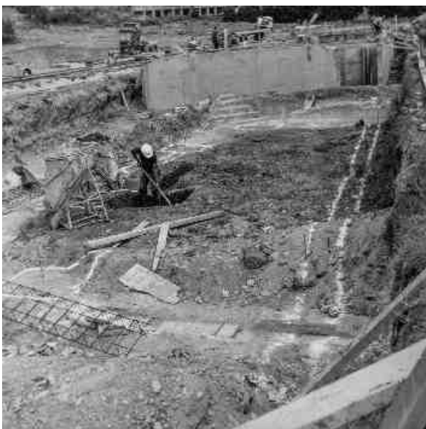
Construction d'un immeuble sur les vestiges de la piscine romaine, 1966 Photographie Georges Baccrabère © MSR
