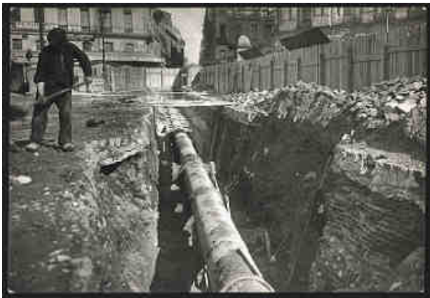
Photographie L. Fachinetti, Pose de canalisations d'égout, 1910 © Archives municipales de Toulouse
